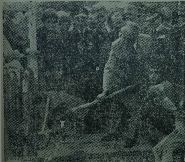
Vali Karasarlıoğlu Hükümet binasının temelini atarken görülüyor.
