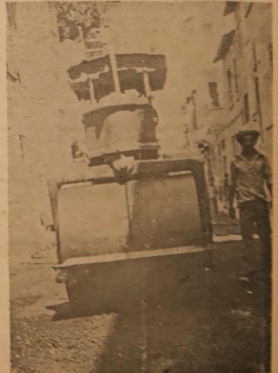
1. Nolu caddeden başlayan asfalt çalışmalarından görsel
