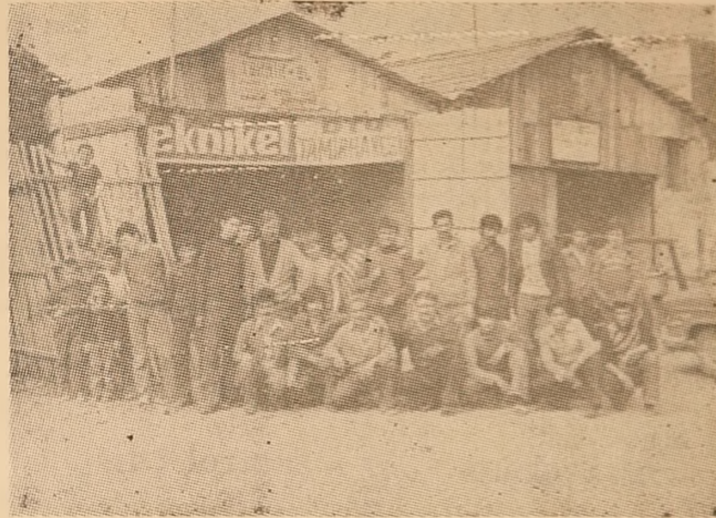
Kamyon Garajındaki 18 esnaf, Sağlık Ocağı yapılacağı için işyerlerinden çıkartılıyor.
