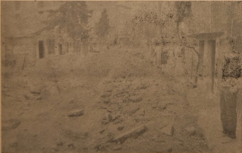
Gemlik'in en kalabalık caddelerinden biri olan Pazar caddesinin beton yol yapımına başlandı. Fotoğrafta, pazar caddesiyle birleşen garaj arkasının, yol yapımı için kazılmış hali görülmektedir. (●, Körfez - İhsan BÖLÜK)
