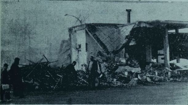
Resimde rıhtımda bulunan Lokanta ve gazinoların yıkım çalışmaları devam ederken görülüyor.
