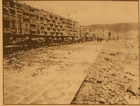
Lodos fırtınası Atatürk ve Emin Dalkıran Kordonu'nda hasara yol açarken, dolgu kayaları dalgaların şiddeti ile koca kaya parçalarını yerlerinden oynattı, kaldırımları söktü.
