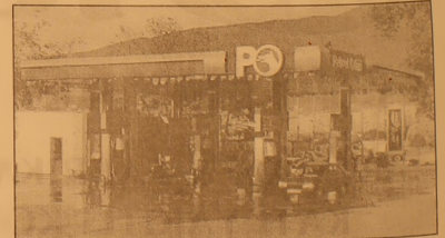
Dörtgöl girişindeki istasyonumuzun önden görünüşü.
